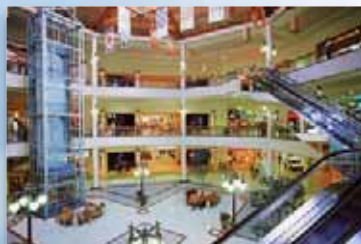
■ Gestion Technique du Bâtiment
