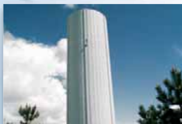
■ Traitement de l'eau
